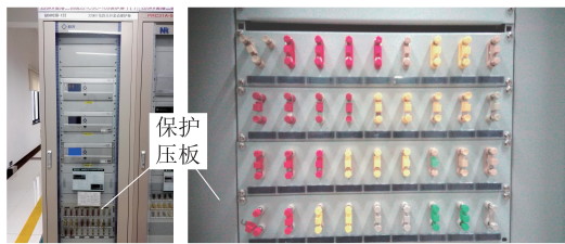
图 13 巡检机器人采集的二次设备压板图像
