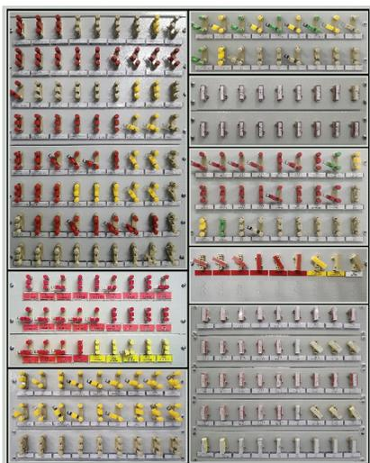
图 2 部分压板开合状态典型样本
