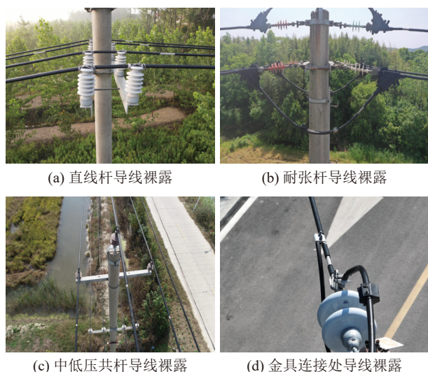
图 6 导线裸露示例
